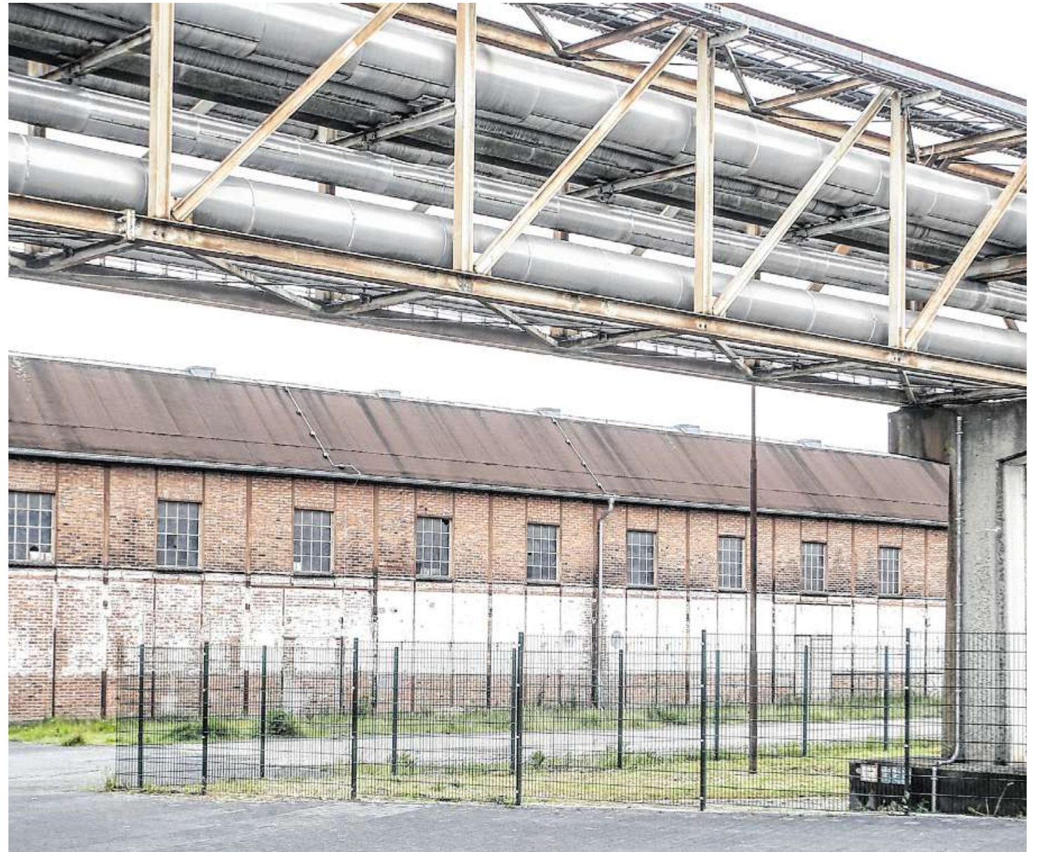
Die Sportgemeinschaft Aumund-Vegesack möchte die alte Fliegerhalle nutzen und dort ein Schwimmbad bauen.
