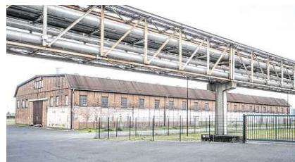
Die Schwimmabteilung der SG Amund-Vegesack (SAV) möchte die alte Fliegerhalle auf dem früheren Industriegebiet nutzen und dort ein Schwimmbad bauen lassen. FOTO: CHRISTIAN KOSAK
